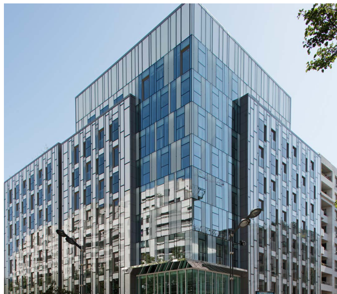
MALRAUX - LEVALLOIS PERRET Bouchaud Architectes | Antonio Maniscalco
